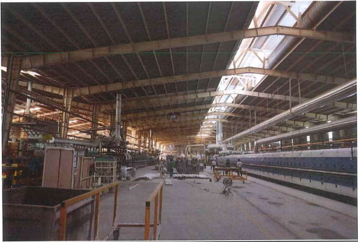
Hệ thống lò nung gạch liên tục và đường ống thu hồi nhiệt
