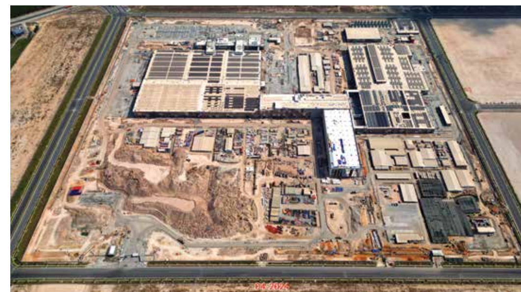
Toàn cảnh hình ảnh công trường thi công.
