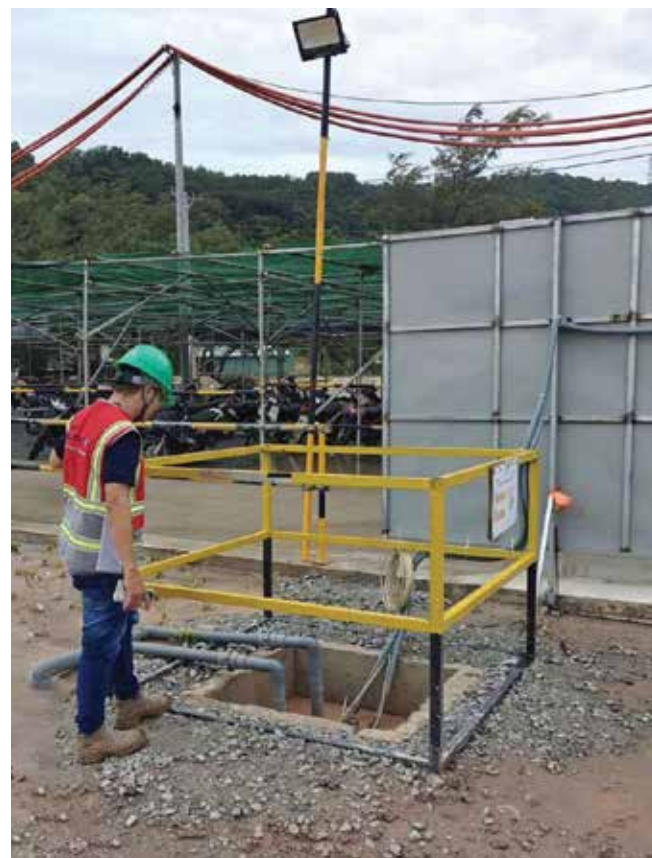
Giám sát môi trường, kiểm tra hệ thống thu hồi, xử lý nước thải dự án Trung tâm Hội nghị APEC (An Giang).
