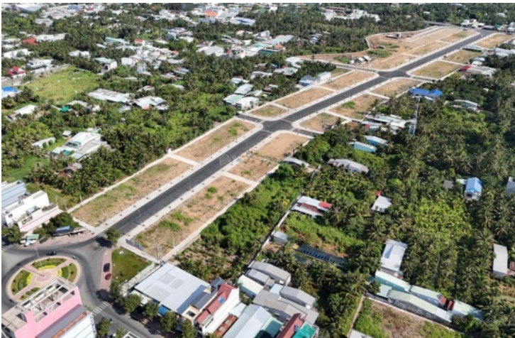
Hình 8: Dự án đường D7 và khu dân cư hai bên đường của THG
